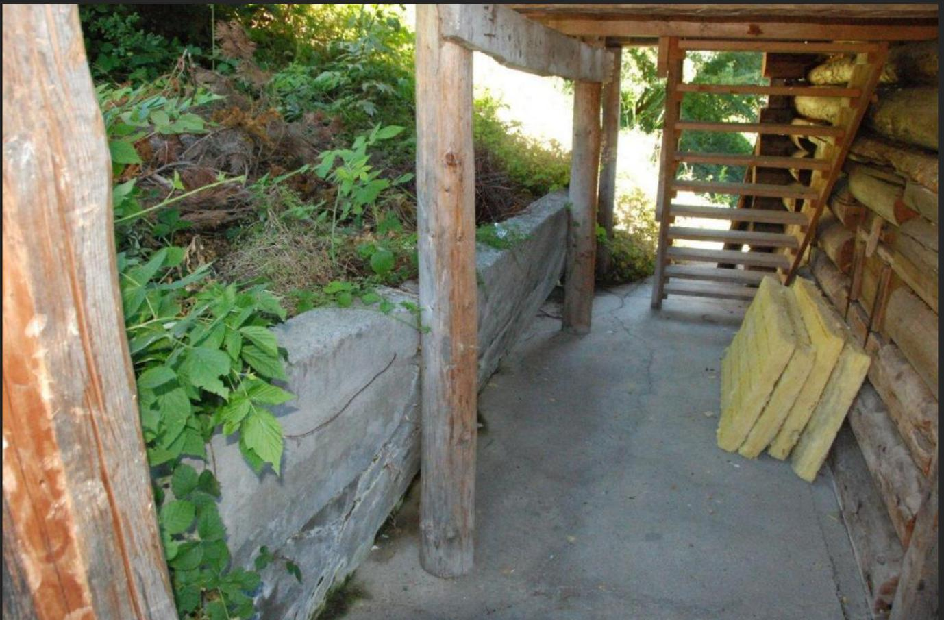
Die eindrückende Betonmauer gibt deutlich zu erkennen, dass eine Renovation dringendst notwendig ist.
